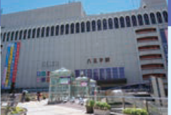
八王子エリア 八王子駅ビル
